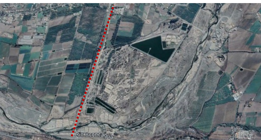
Vista aérea del río Aconcagua, las lagunas de infiltración y la planta de tratamiento de aguas. La ubicación del dren Las Vegas está resaltada en rojo (foto: Google Earth, 2021).
