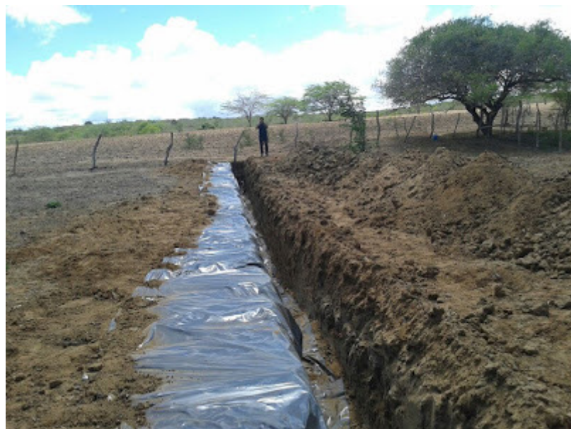
Construcción de una presa subterránea en Campina Grande, estado de Paraíba (foto: R. Diniz).
