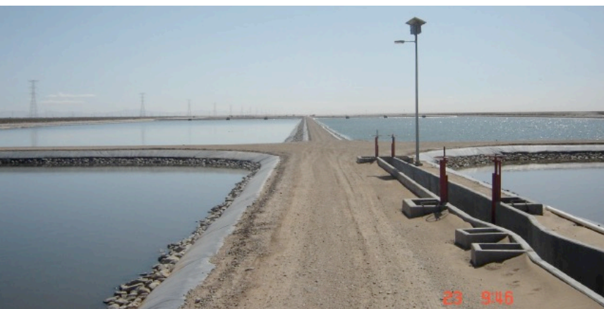
Cuencas de infiltración en operación de 0,014 km 2 cada una. Coste total aproximado de la infraestructura es 660.000 dólares (foto: H. Hernandez).
