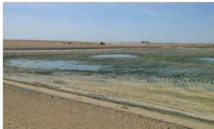
Colmatación del fondo de la laguna de infiltración, lo que provoca una reducción de la infiltración y la pérdida de la homogeneidad de la superficie (foto: Humberto, H. A. M., Raúl, C. C., Lorenzo, V. V., & Jorge, R. H. 2018).
