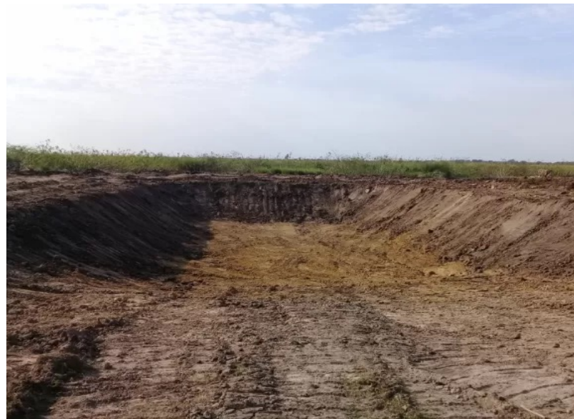
Remoción de sedimentos en un estanque de infiltración (foto: E. Iglesias).
