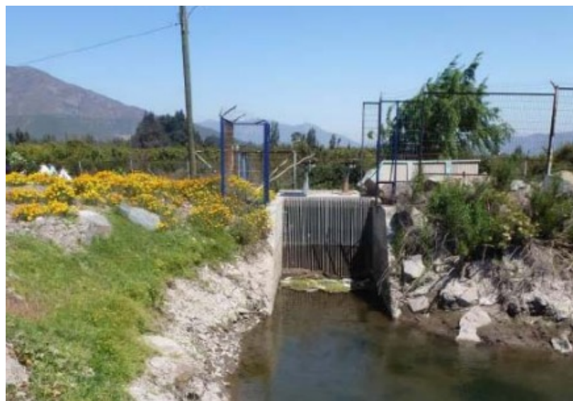
Captación superficial que desvía el agua del río Aconcagua hacia la planta de tratamiento de agua de Las Vegas (foto: SISS, 2014).
